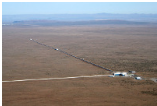
Figure 15: 引力波观测站 (Hanford) 外貌。照片来自 Caltech/MIT/LIGO Lab。
